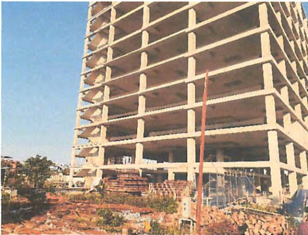
建設中のベトナム・日本国際総合病院現場見学
